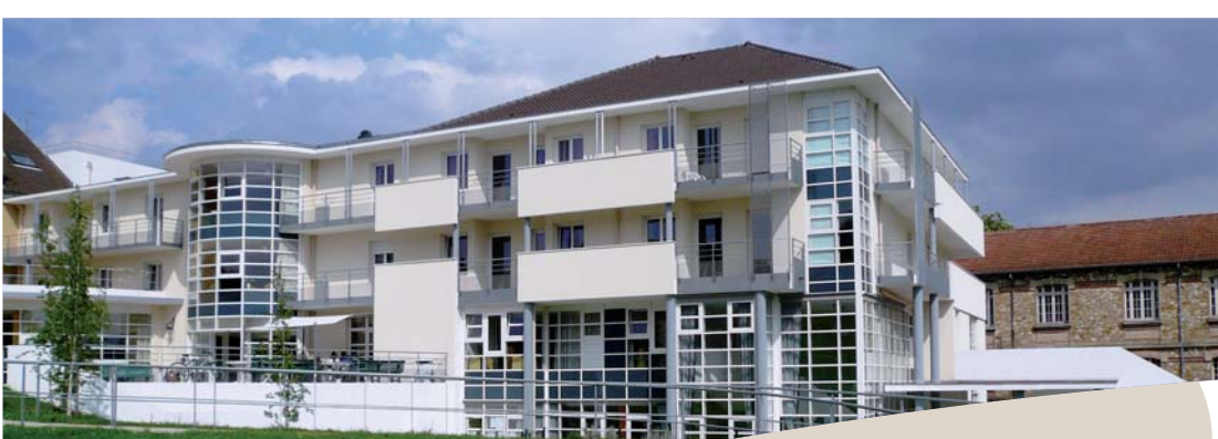
CORMEILLES-EN-PARISIS (95) - 48 rue Aristide Briand Fondation Chabrand-Thibault Travaux de réhabilitation et d'extension de l'EHPAD de 109 places
